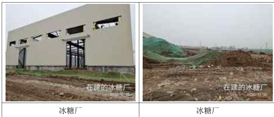
图 3.4-1 地块周边现状实景图
